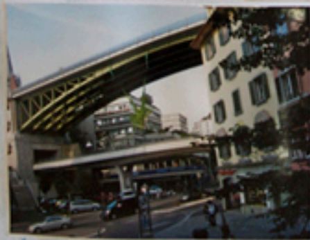
Toile d'araignée du pont Bessière
